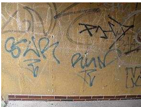
popraskané spáry pórobetonové přizdívky
