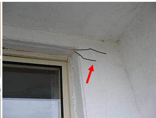
praskliny mezi stykem stropního lodžiového panelu a obvodovým panelem, mezi panely
