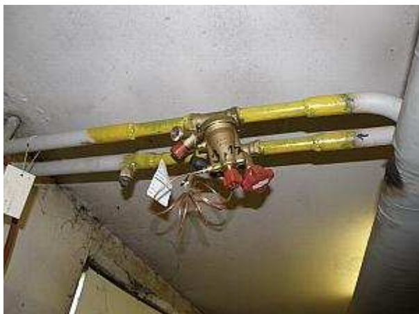
Chybějící izolace na potrubí
