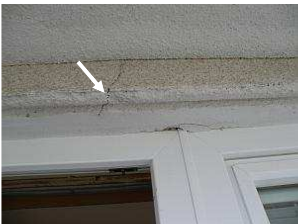
prasklina ve spodní části obvodového panelu, který tvoří nadpraží čelní balkonové stěny
