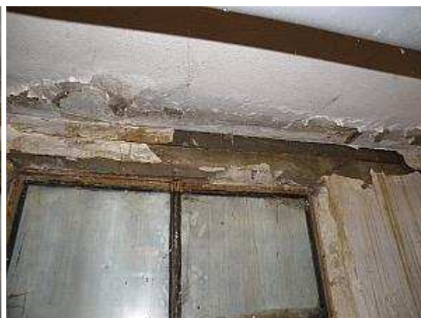
popraskané spáry pórobetonové přizdívky
