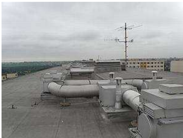
pohled na střechu
