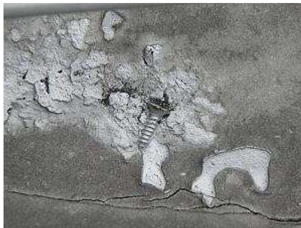
šroub přetřený reflexním nátěrem ☺
