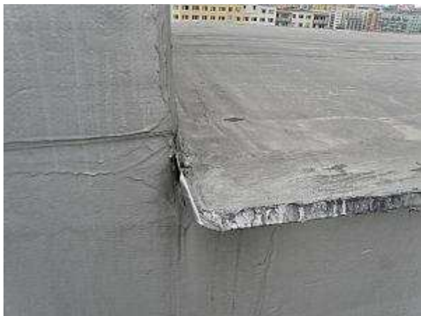
Spáry v místech detailů – návaznost na oplechování
