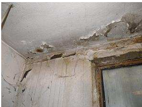
poruchy v 1.PP v místě dilatační spáry
