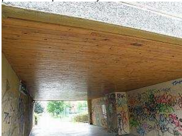
Palubkový obklad stropní konstrukce
