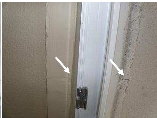
prasklina ve spodní části obvodového panelu, který tvoří nadpraží čelní balkonové stěny
