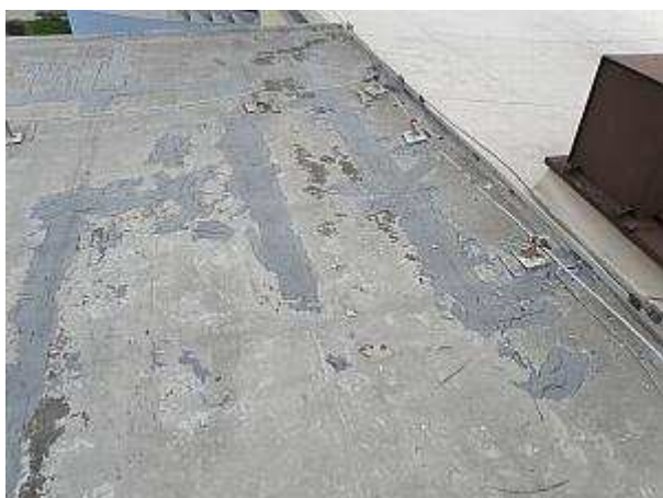
Praskliny i v místech provedených lokálních oprav povrchů
