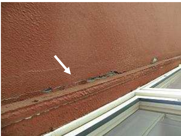
praskliny mezi stykem stropního lodžiového panelu a obvodovým panelem, mezi panely
