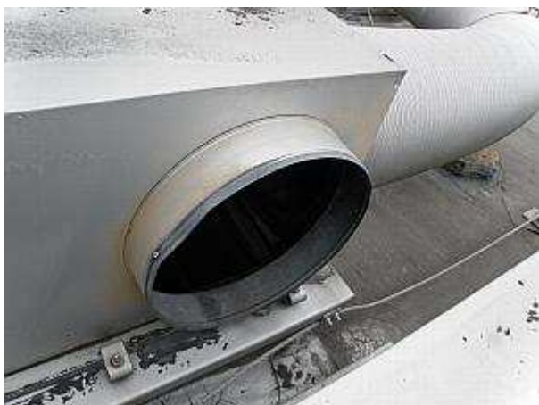
chybějící víko u sběrné komory vzt
