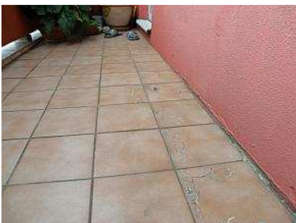
použití dlažby bez mrazuvzdorné odolnosti, špatné vyspádování dlažby
