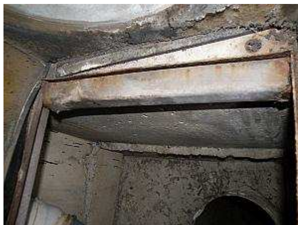
zkorodovaná kapotáž konstrukce sběrné komory
