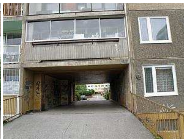
pohled z východní strany
