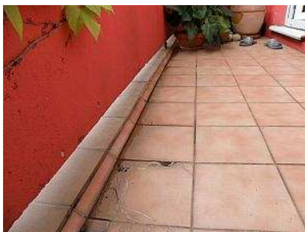
použití dlažby bez mrazuvzdorné odolnosti, špatné vyspádování dlažby
